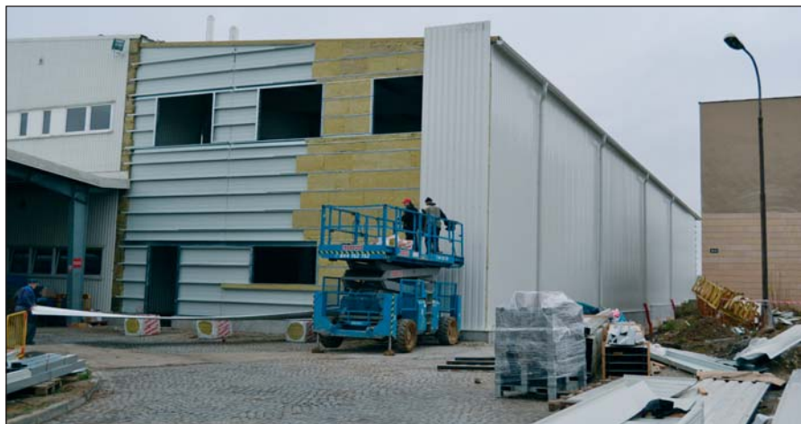
Stavba další části haly montáže
